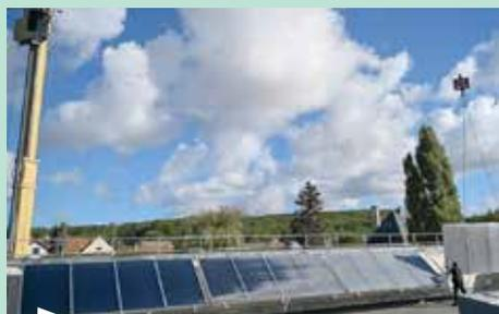
Les panneaux solaires placés sur le toit du centre aquatique ont fait peau neuve. Après plusieurs mois de travaux, l'installation remise en route fournit une production constante d'eau chaude à destination des douches et du bassin intérieur d'Hudolia.
