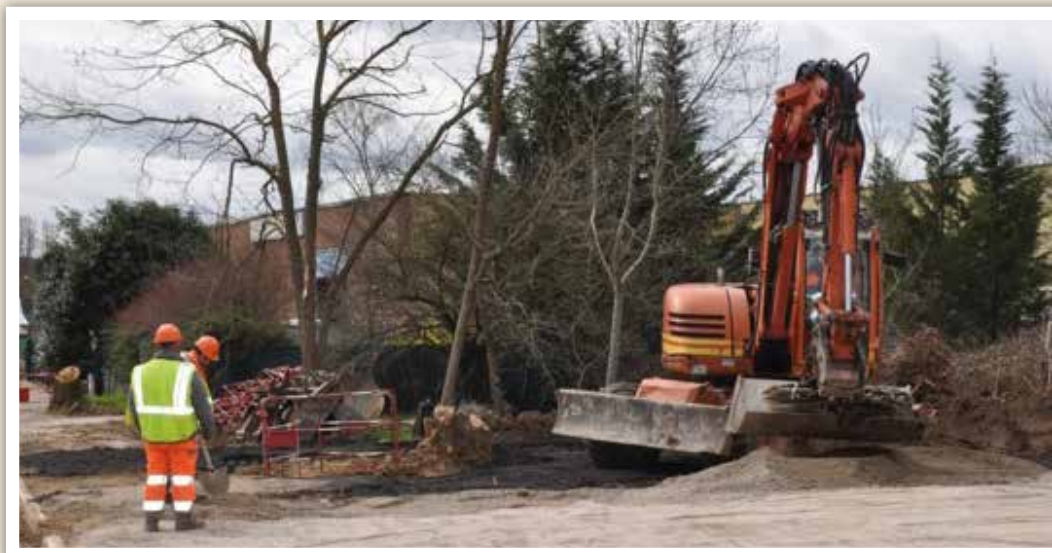
Rue de la Gaudrée les travaux de terrassement impliquent la mise en sens unique par demi-chaussée.
